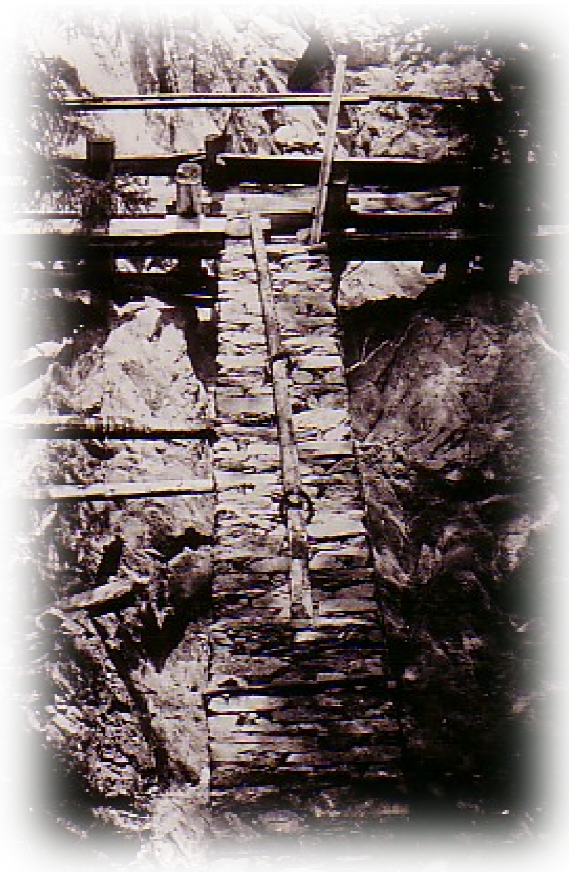
Particolare delle antiche strutture del Ru Courtaud
