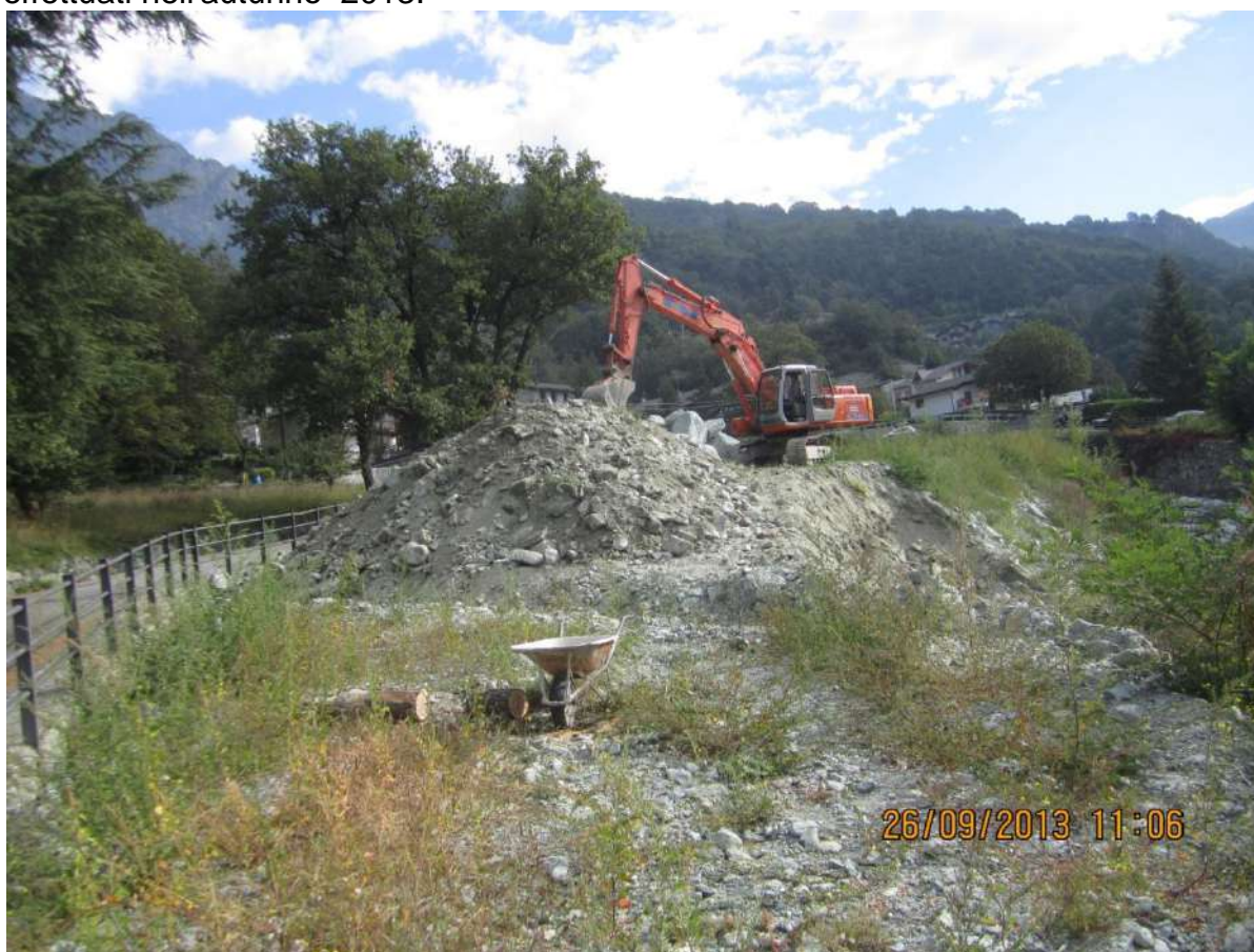
Foto dei lavori datata 26.09.2013
