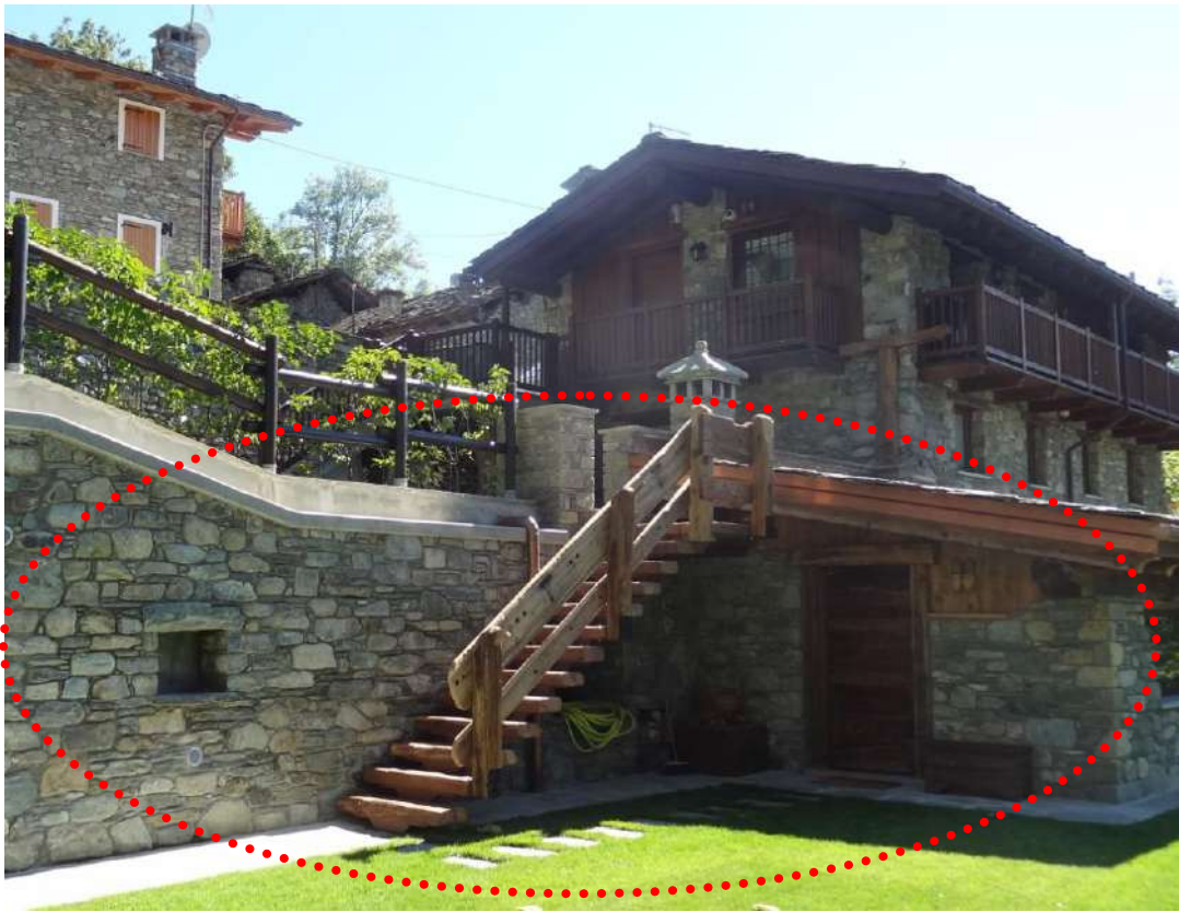
Foto 2 - Fabbricato sito al Fg. 6 mapp. n. 1040
