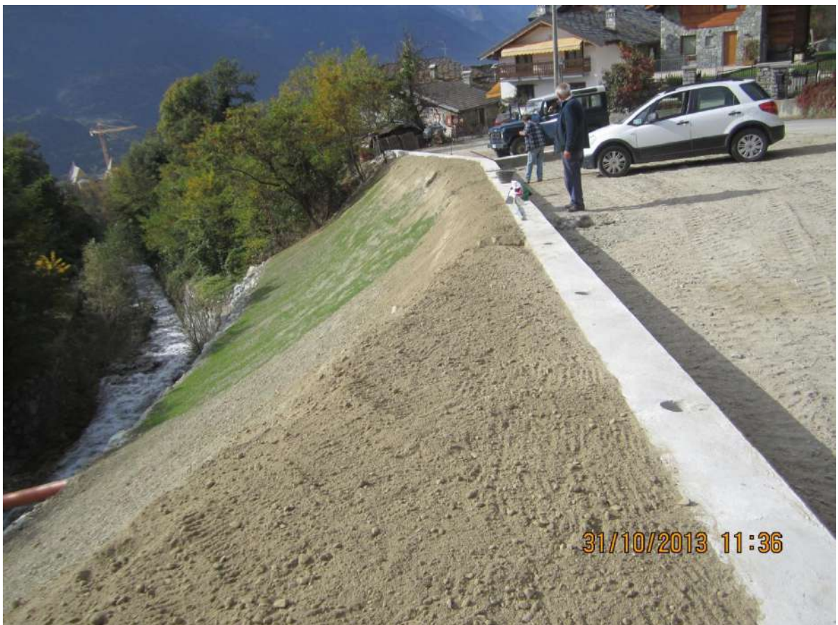
Foto dei lavori datata 31.10.2013
