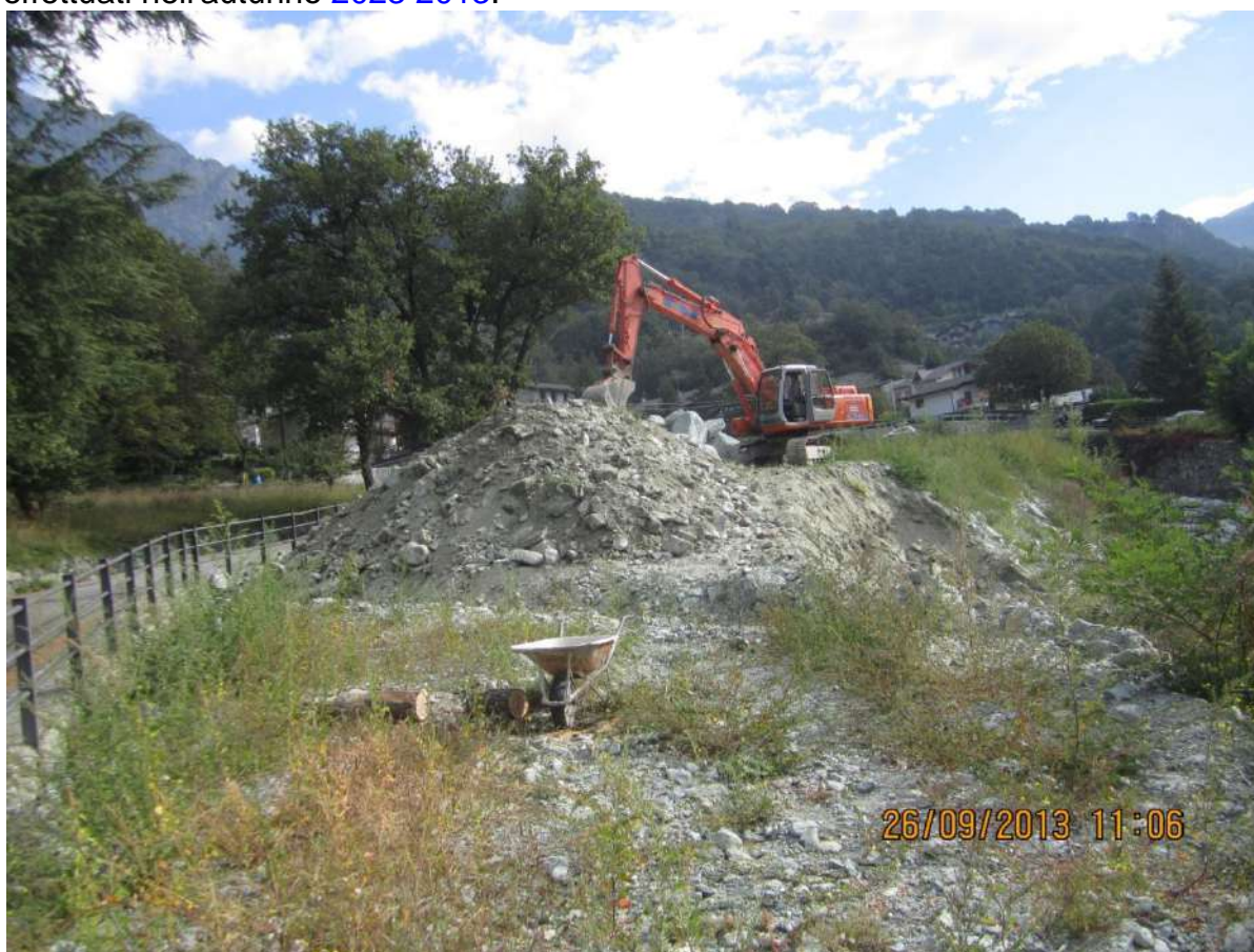
Foto dei lavori datata 26.09.2013
