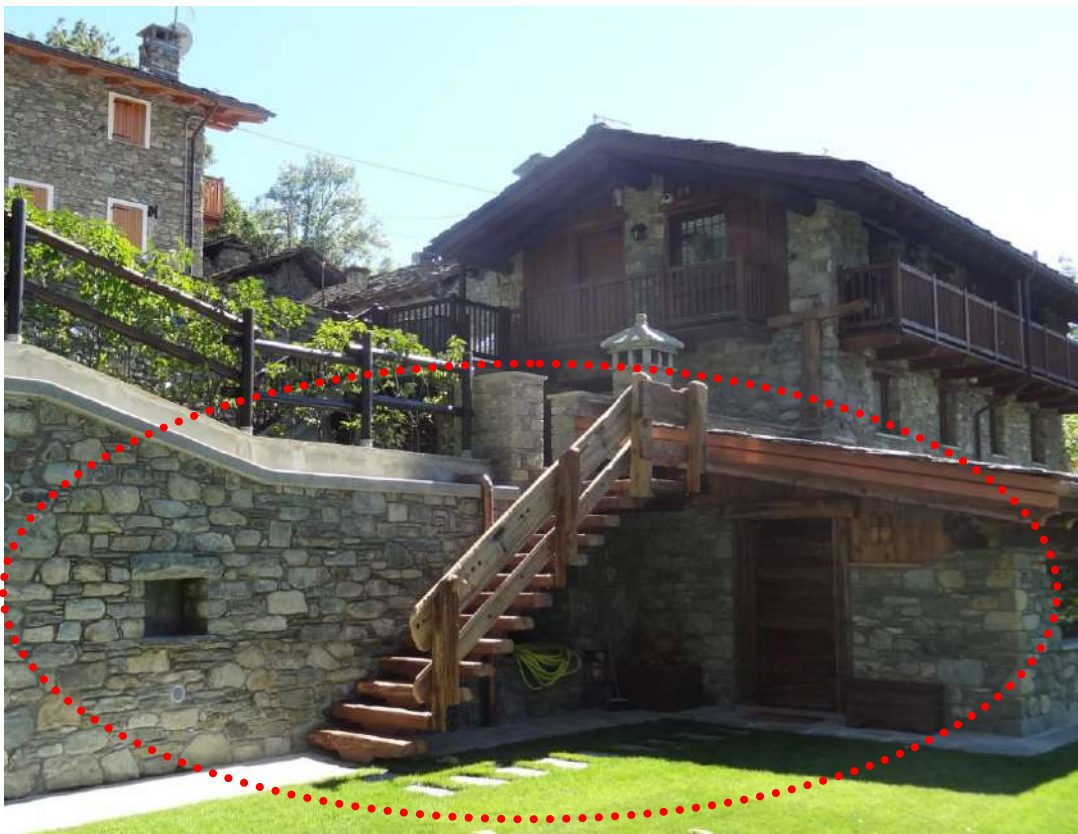
Foto 2 - Fabbricato sito al Fg. 6 mapp. n. 1040
