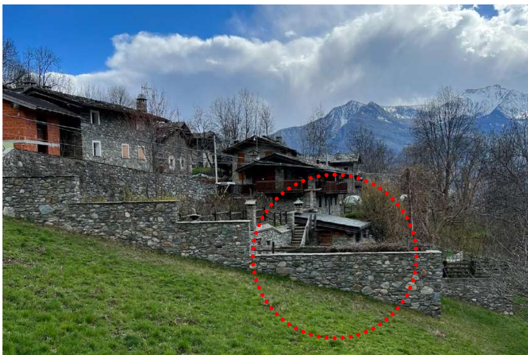
Foto 1 - Fabbricato sito al Fg. 6 mapp. n. 1040
