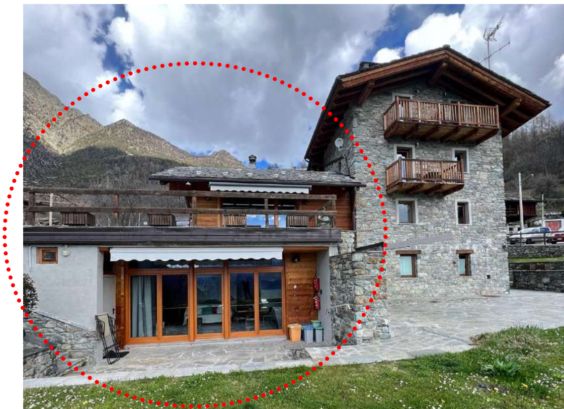
Foto 3 - Fabbricato sito al Fg. 6 mapp. n. 131
