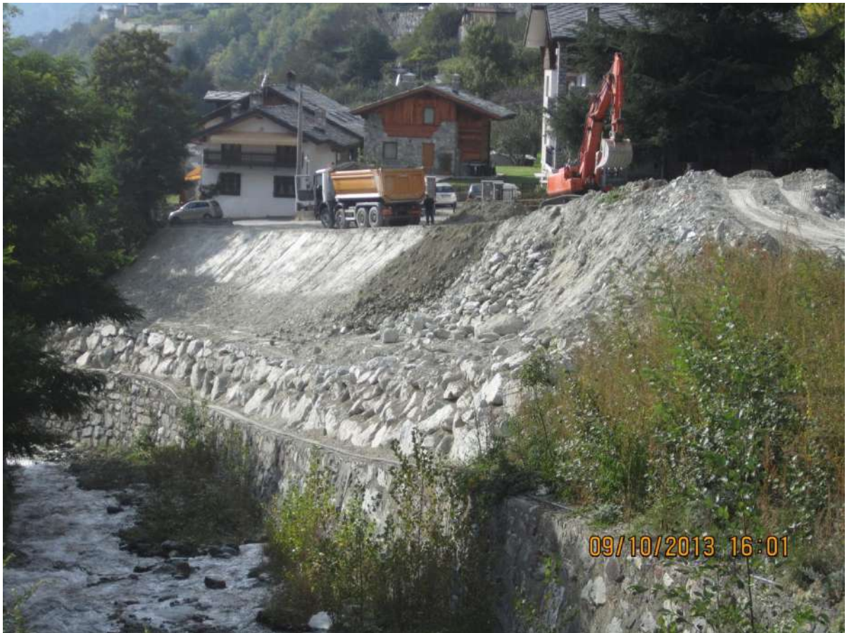
Foto dei lavori datata 09.10.2013
