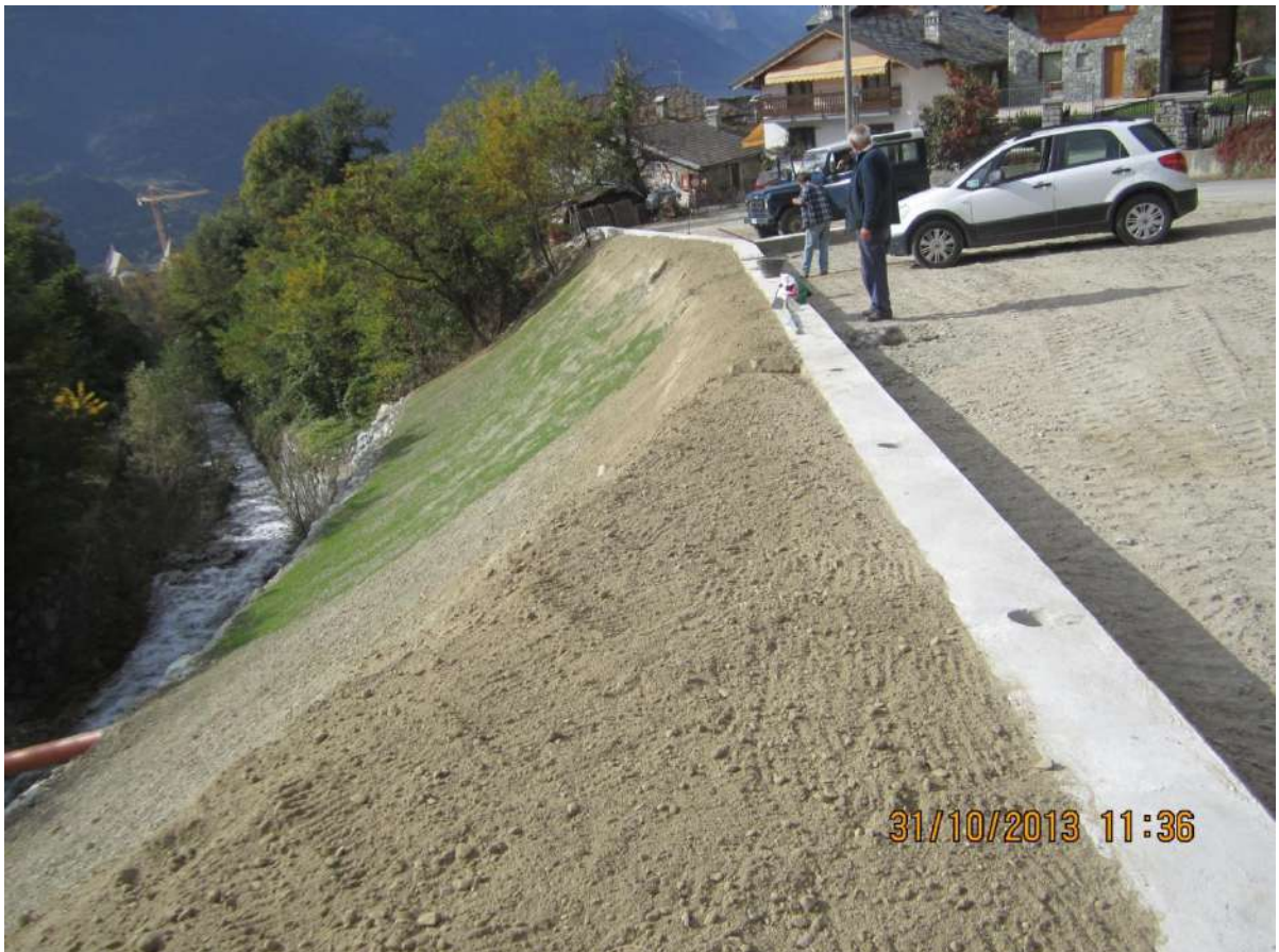
Foto dei lavori datata 31.10.2013
