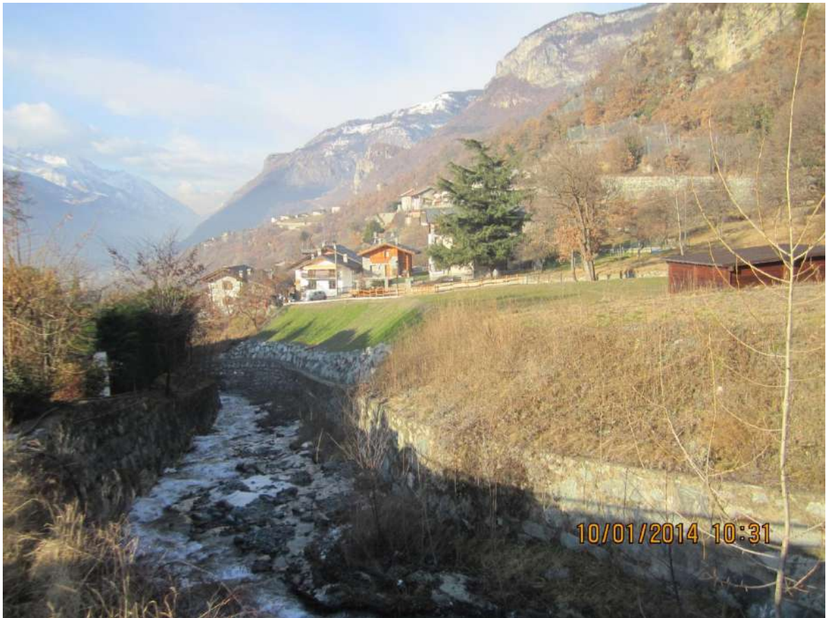
Foto dei lavori datata 31.01.2013
